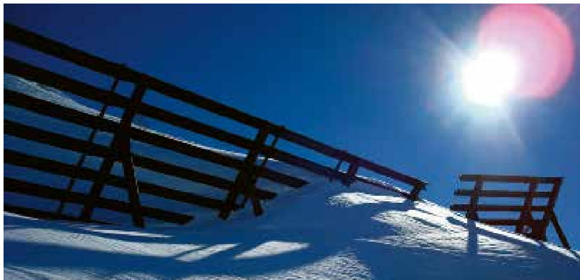
Eingeschneite Schneebrücke vom Typ SB, DK 4,0 m im Anbruchgebiet Val- latsch II Pignia GR.
