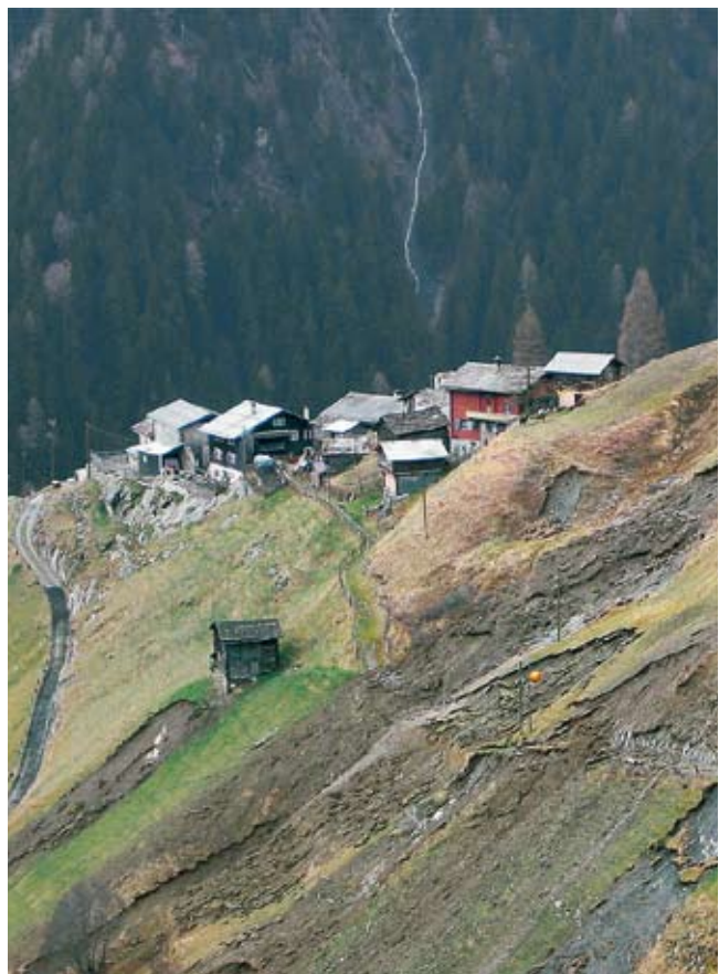
Rutschungen mit viel Wasser im Untergrund ergeben Hangmuren, Munt November 2002
