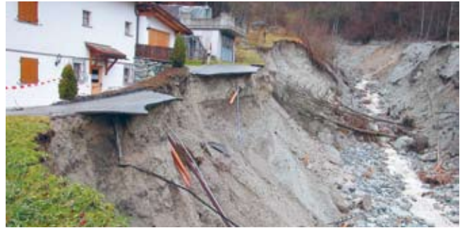
Seitliche Erosion von bis zu 7 m, Rueun November 2002
