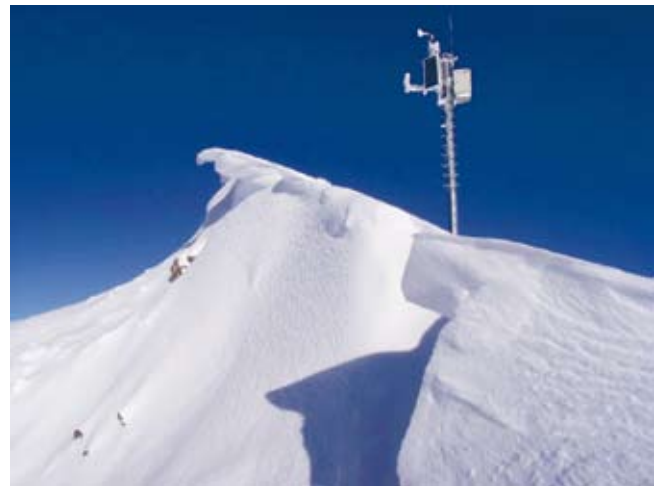
Messstation für Schnee, Niederschlag, Wind etc.
