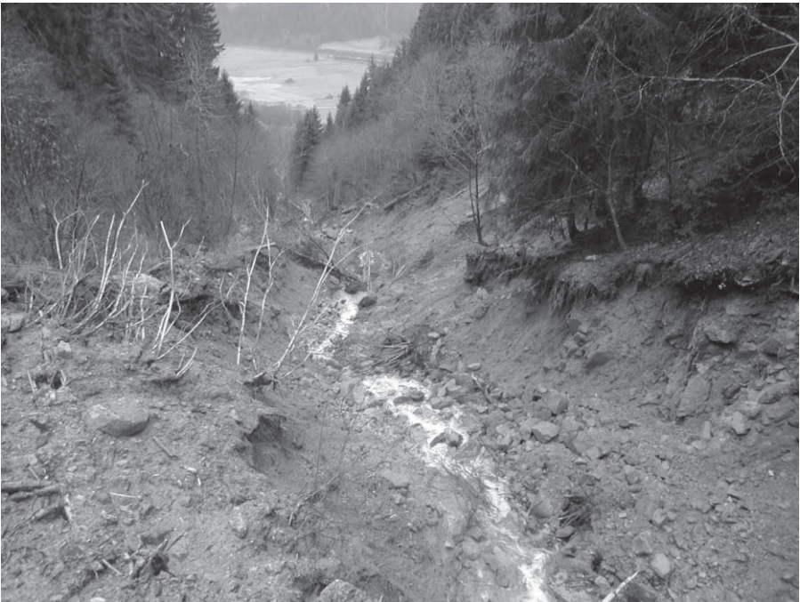
Abb. 4: Beträchtliche Tiefen- und Seitenerosion im Hauptgerinne des Val Campliun
