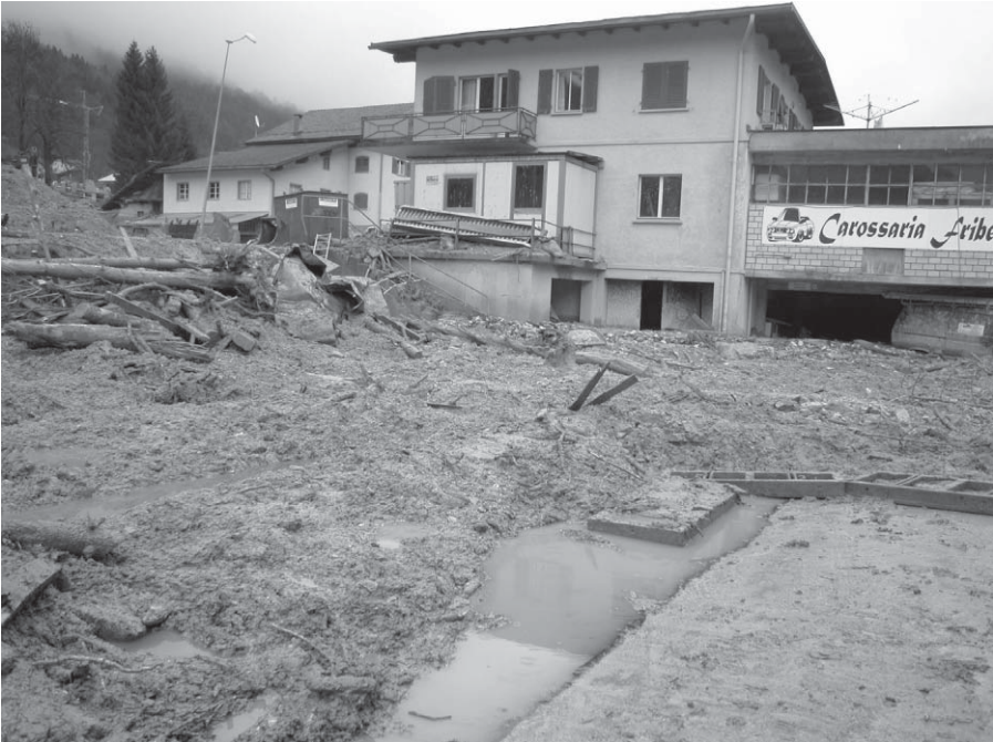
Abb. 7: Ablagerungen im Kegelbereich des Val Valdun führen u.a. zu starken Gebäudeschäden
