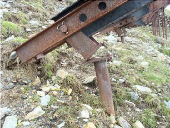
**Abb. 7.2.1:** Abgerissene Stahlplatte
