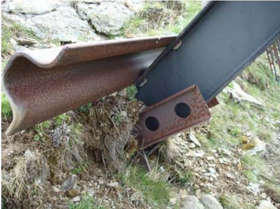
**Abb. 7.2.3:** Abgedrehte Gabel sowie stark aufgerichteter Träger der Werkreihe 41
