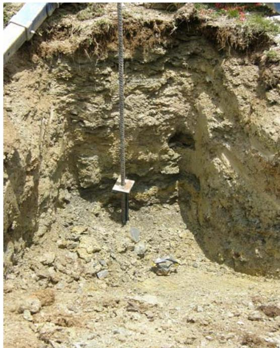
**Abb. 6.8:** neuer Anker 009 ohne Mörtel (Mörtel abgefallen)
