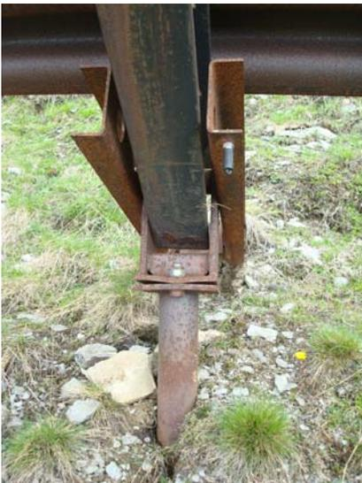
**Abb. 7.2.2:** Zu grosser Überstand des Mikropfahlrohres der Werkreihe 41
